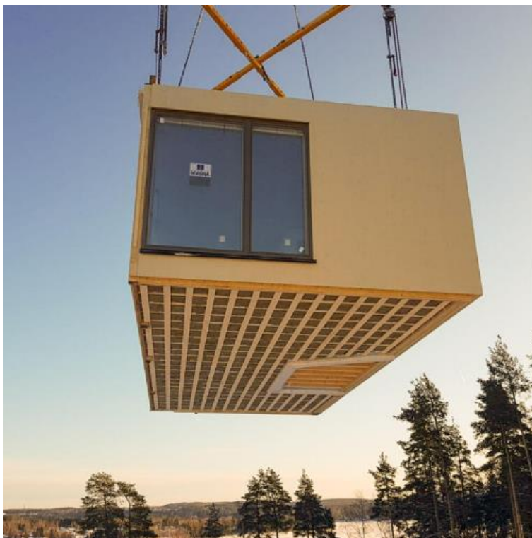
Moduulin nosto kohteeseen. Kuva jvr.fi
