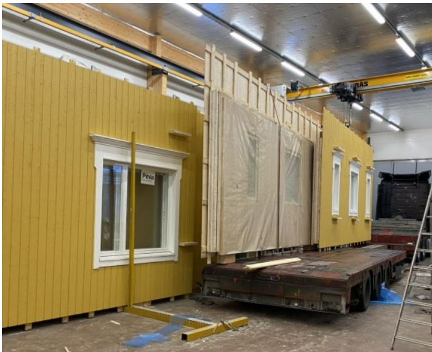
CLT omakotielementit lähdössä asennettavaksi. Kuva: kiukkonen.fi
