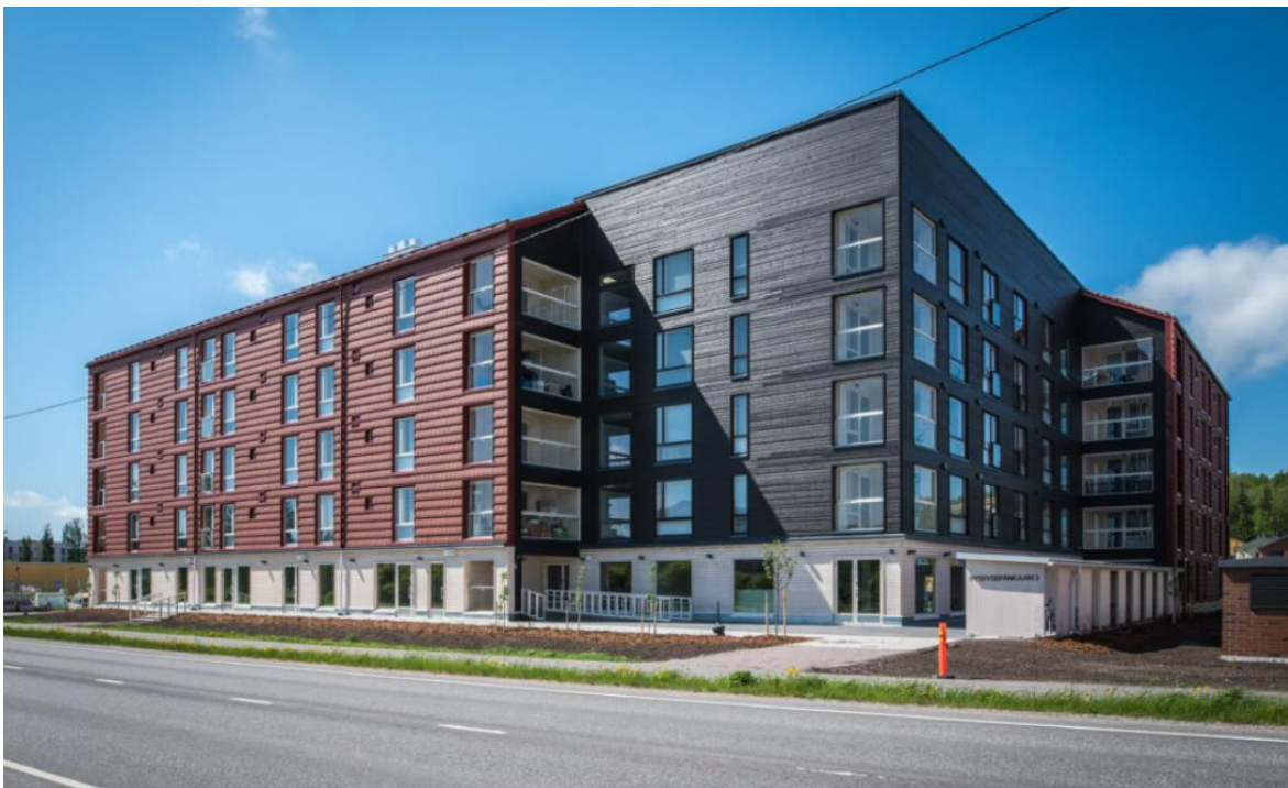
Kirkkonummen vuokra-asunnot Oy, Pysysepänkaari 3. Rakentaja JVR -Rakenne Oy.
